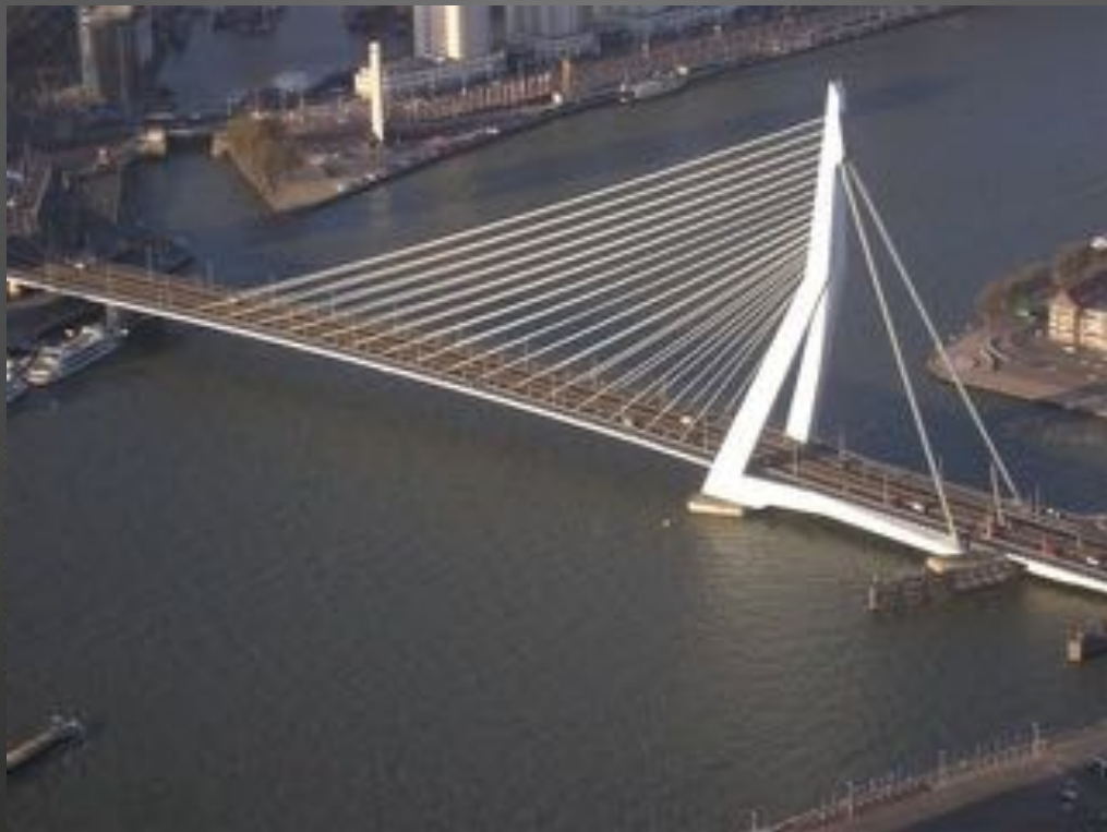
Erasmusbrug (Erasmus Bridge), Ben van Berkel, Rotterdam, Netherlands, 1996
