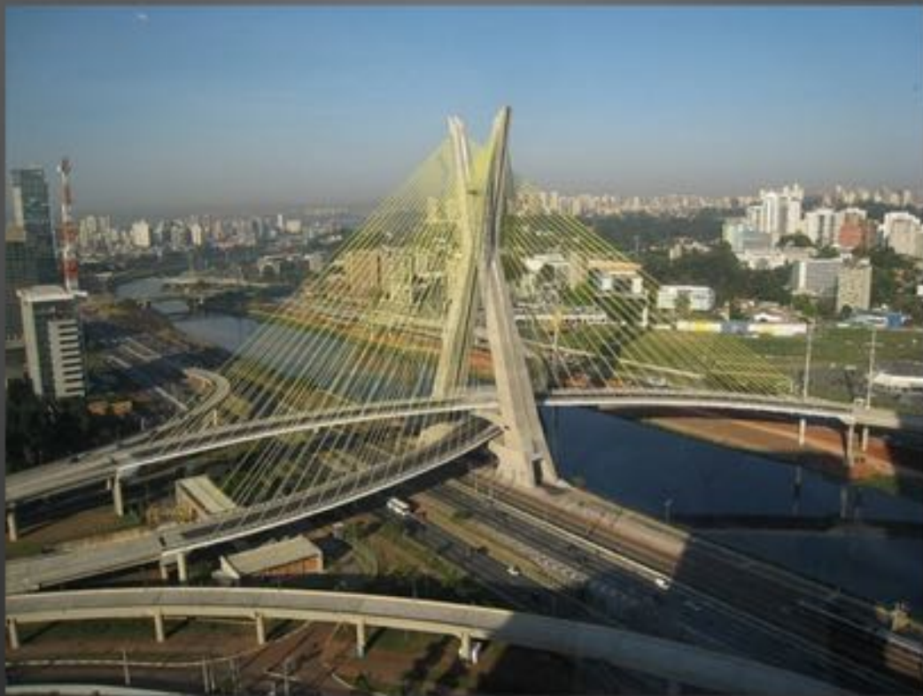
Octavio Frias de Oliveira Bridge, João Valente Filho, São Paulo – SP, Brazil, 2008
