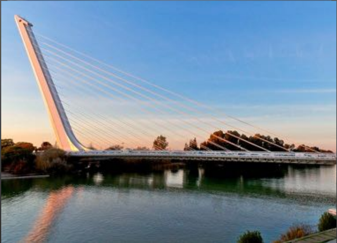
Puente del Alamillo, Santiago Calatrava, Seville, Spain, 1992
